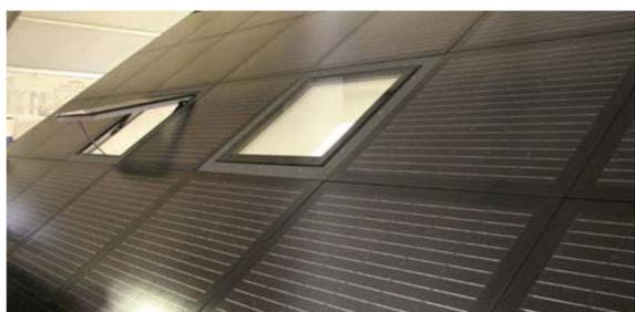
Die Photovoltaikausenhaut erzeugt eine homogene Fassade.
