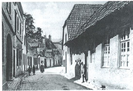
Kurze Kesselstraße in Warendorf (um 1920) und Doppelgaden in der Kurzen Kesselstraße 13/15 (Rekonstruktion um 1600)
