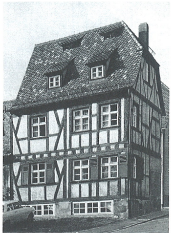
Ansicht eines Hauses aus der Siedlung »Die Sieben Zeilen« in Nürnberg (erbaut 1524). Über dem Keller, in dem sich die Webstühle befanden, lagen zwei Fachwerkgeschoße mit Stube, Küche, Kammer (1966)
