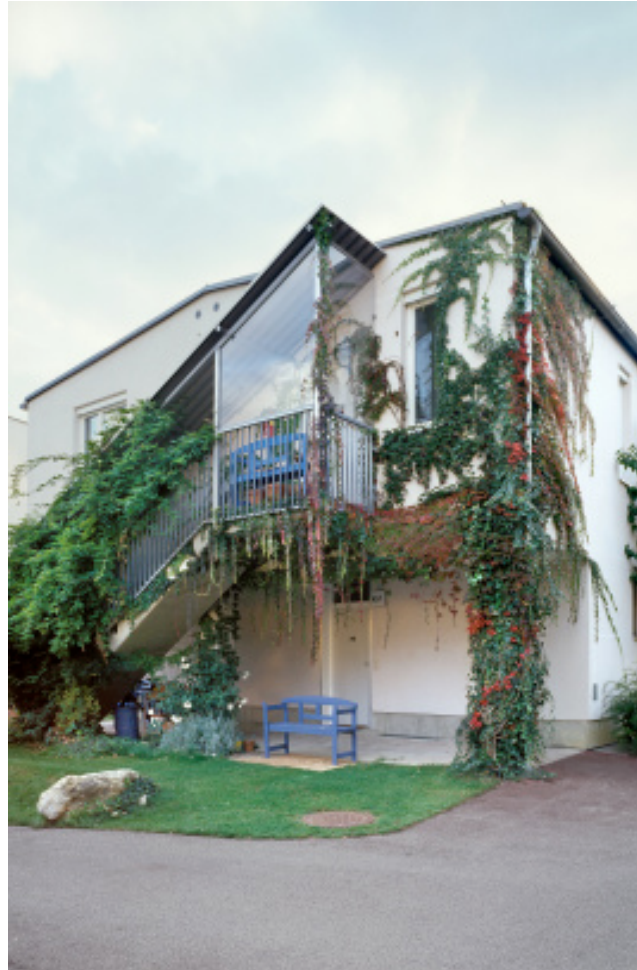
Wienerbergersiedlung Erskine and Riess 1985
