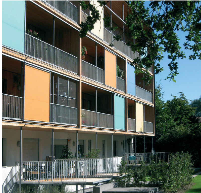
Abb. 11.2: Südfassade nach der Sanierung, Bild: Architekturbüro Reiszky
