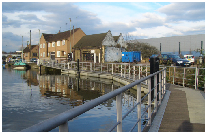
Blick Nr.2: Schwimmende Fußgängerbrücke
