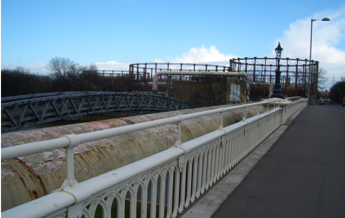
Blick Nr.10:Blick Richtung Gassilos
